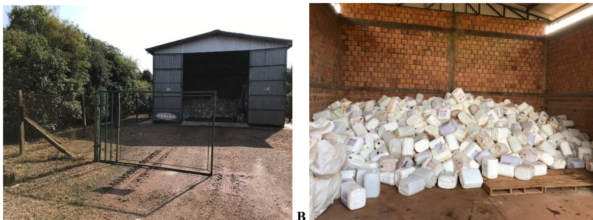
Figura 1 - Imagem externa (A) da parte interna (B) do posto de recebimento de embalagens vazias Arfita. Foto: Autores (2019).
